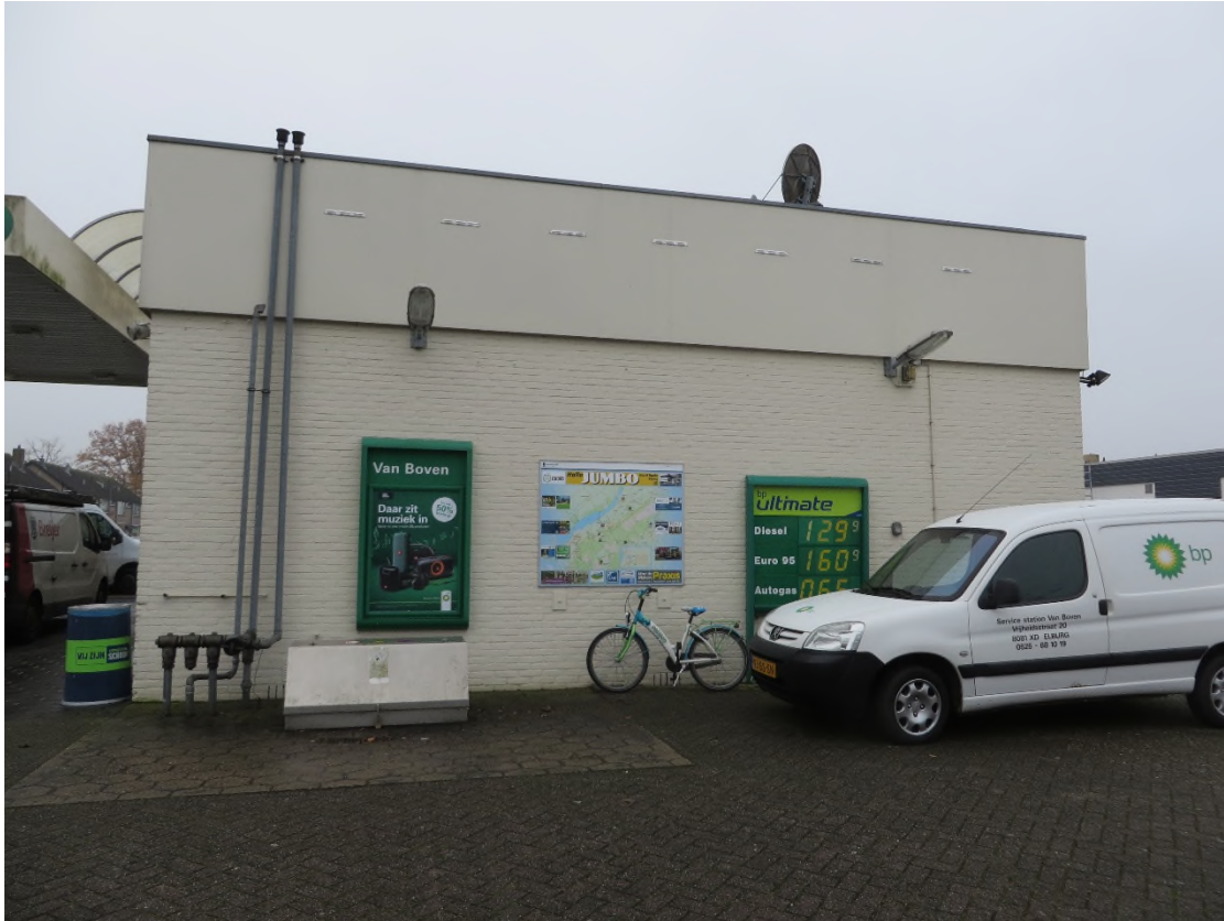
Foto 5. Zijkant van het pand. Er zijn geen open stootvoegen op hoogte aanwezig. Alle kieren zijn goed gedicht
