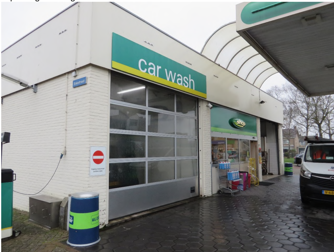
Foto 2. Alle kieren zijn rondom het gebouw geheel afgedicht.
