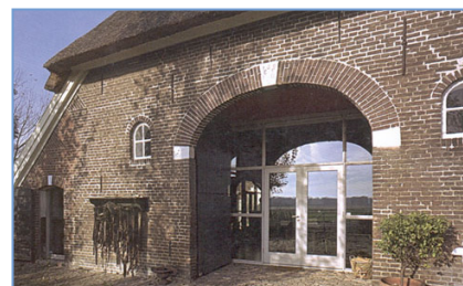
Voorbeelden van een verbouwd achterhuis waarbij de oorspronkelijke gevelindeling en functie van deuren zijn behouden.
