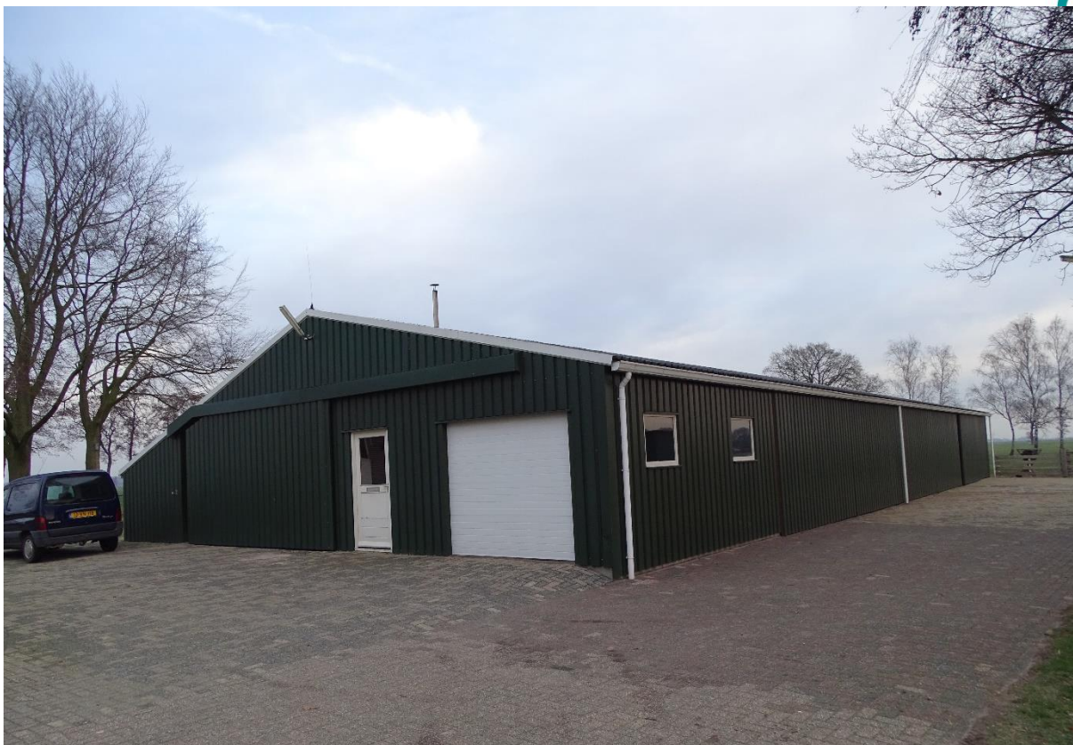
Figuur 2.2. Te slopen golfplaten schuur.
