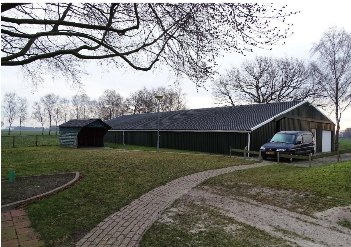
Figuur 2.3. Te slopen houten kapschuur en golfplaten schuur.
