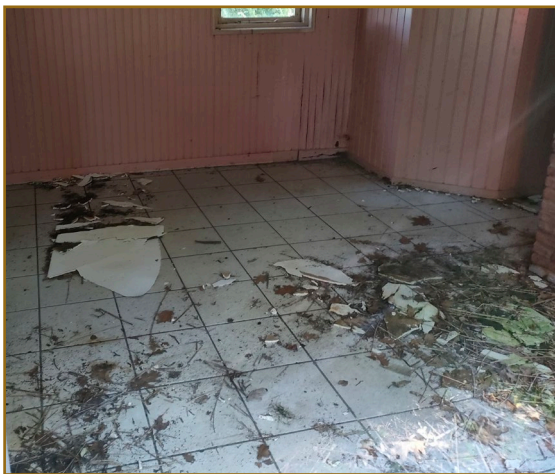
Afb. 2.7: Binnenzijde van vervallen vakantiewoning is goed overzichtelijk en sporen van beschermde soorten ontbreken.
