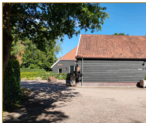
Afb. 2.4: Pannendaken geschikt voor soorten als huismus. Deze bebouwing blijft behouden.
