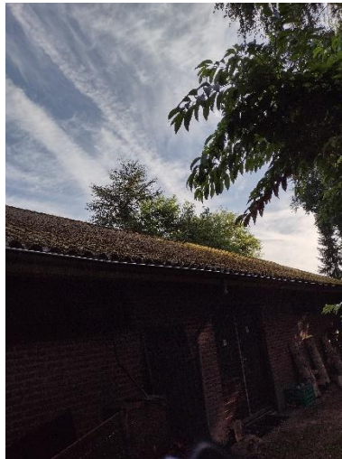
Foto 11: 5c Oude wc gebouw(asbest)
