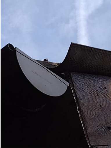
Foto 13: 5e Oude wc gebouw(asbest)
