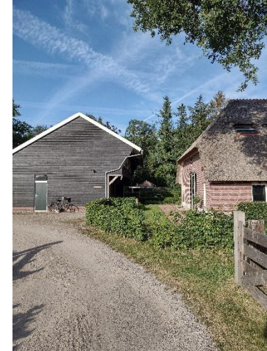
Foto 3: 2b nieuwbouw op brandlocatie
