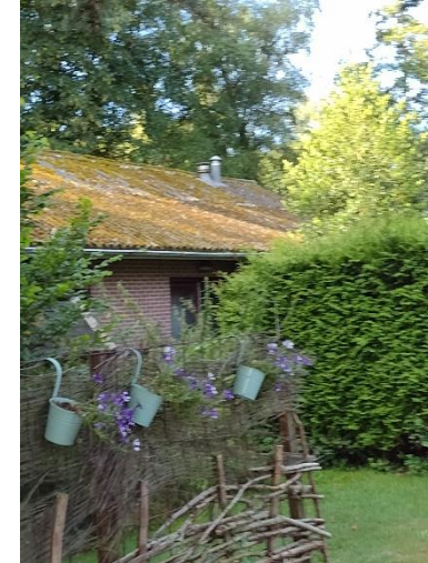
Foto 9: 5a Oude wc gebouw(asbest)
