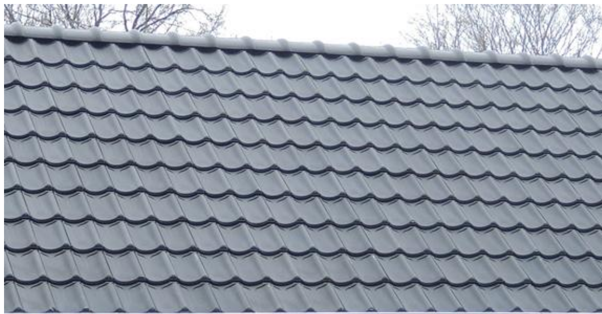
referentie dakbedekking met dakpannen
