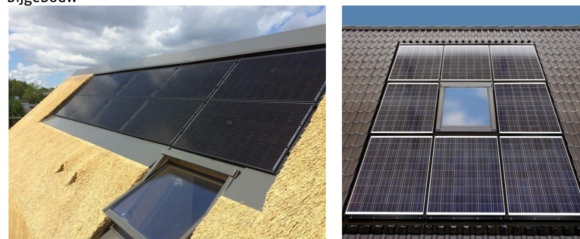
referenties zonnepanelen in het dak
