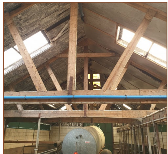
Afb. 1.5: Binnenzijde van de te slopen stal aan de noordzijde
