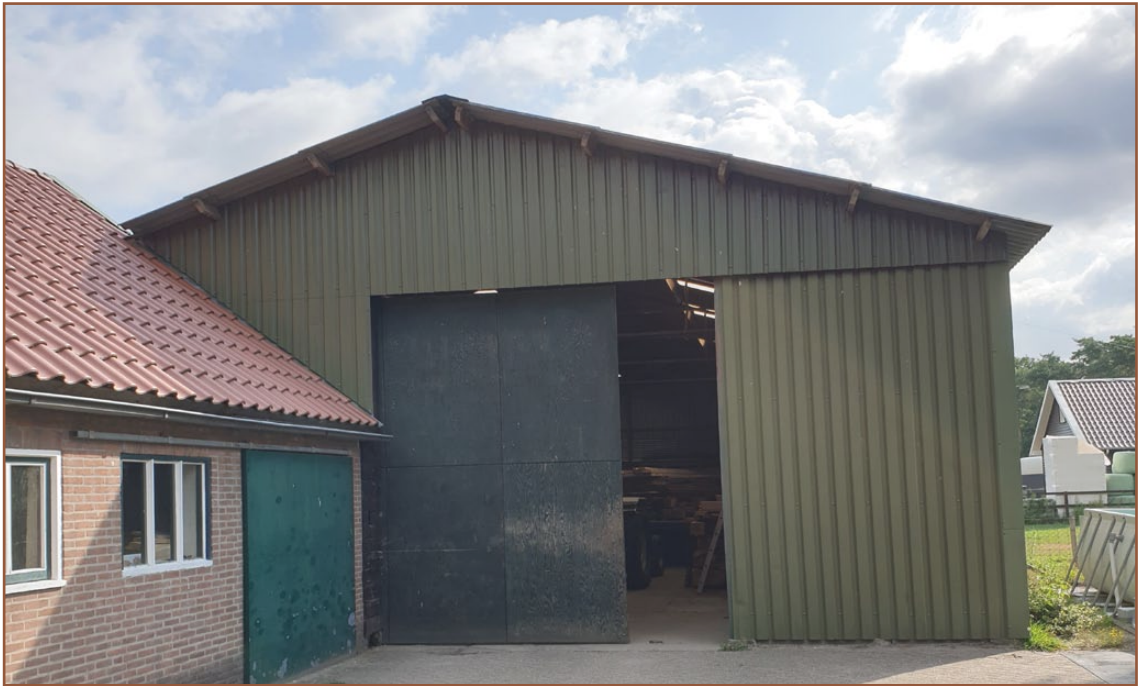
Afb. 1.3: Voorzijde van de te slopen stal op de planlocatie.
