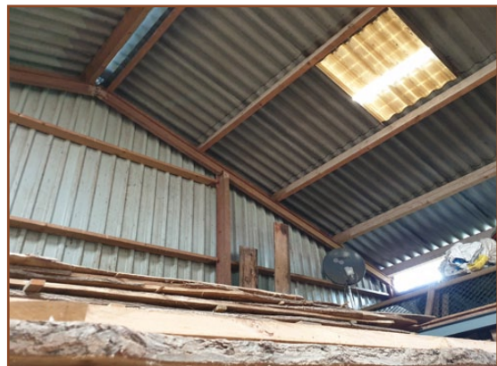
Afb. 2.2: De zuidelijke stal bestaat uit een houten constructie met een golfplaten dak zonder dakbeschoot.
