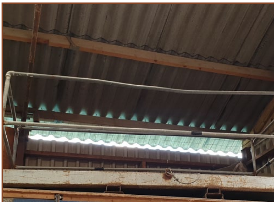
Afb. 2.1: De zijkanten van de stal zijn voorzien van gaas zodat grotere vogels de stal niet kunnen betreden.
