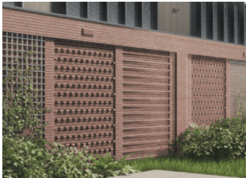
Nieuwbouw onderstation IJburg Amsterdam Powerhouse Architects (2022)
