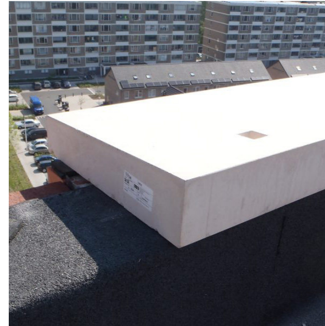
Betonnen dakrand
