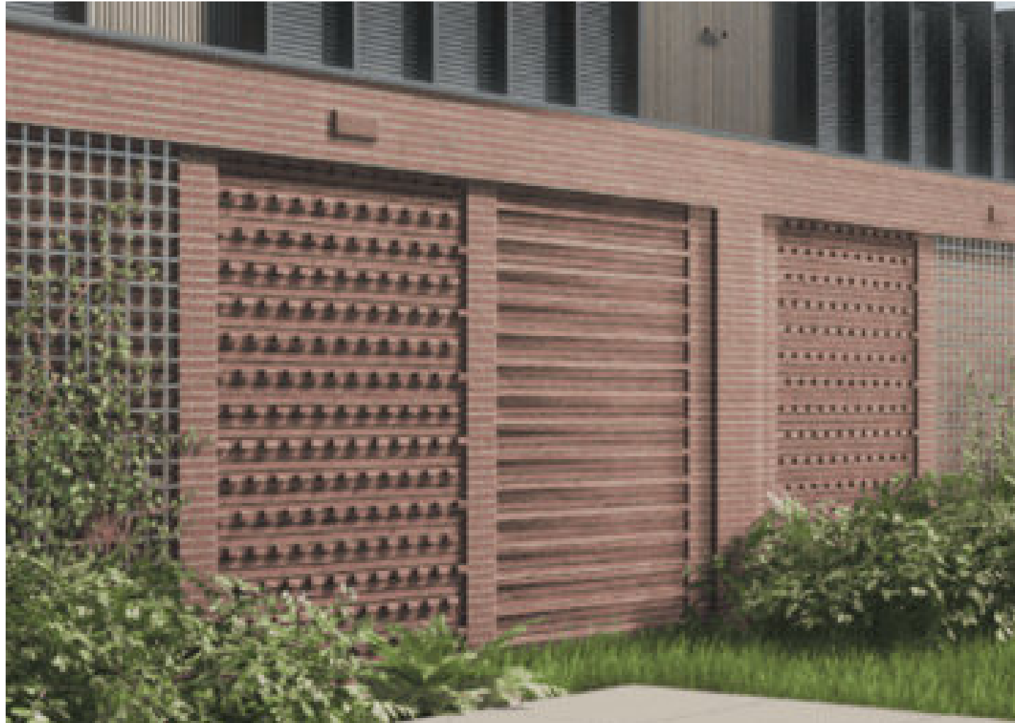
Gevels in baksteen, type nader te bepalen: handvorm steen, rood-bruin genuanceerd, metselwerk in kruisverband met verbijzonderingen
