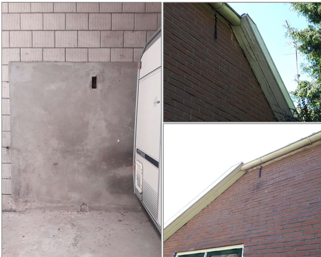
Figuur 4.1 Mogelijk geschikte invliegopeningen voor vleermuizen. Links: opening in de oostgevel van de schuur grenzend aan het woonhuis. Rechts: openingen nabij het dakbeschoot van de voorgevel van de woning. (Foto's: Ecogroen).
