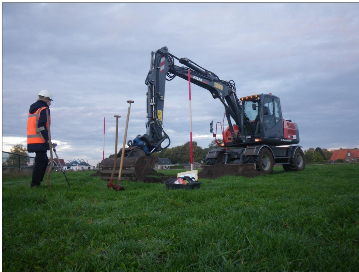
Figuur 4.1 Start van de aanleg van de eerste proefsleuf
