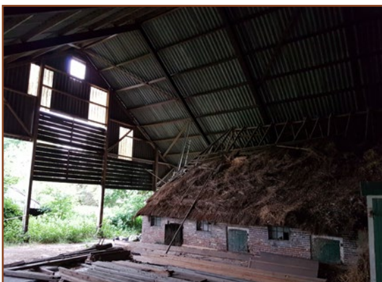
Afb. 2.7: Binnenaanzicht kapschuur richting de grotendeels open oostgevel gezien.
