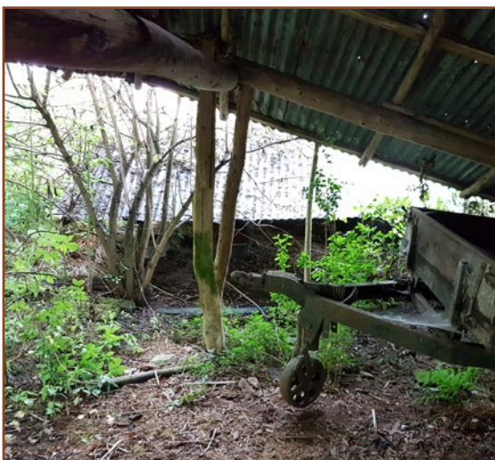
Afb. 2.9: Schuurtjes 6 en 7 zijn opgebouwd uit een houten skelet met metalen golfplaten erover.
