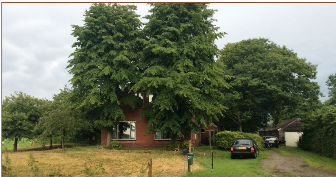
Afb. 2.6: Aanzicht van de te slopen woning, rechts is schuur 3 nog te zien. Foto genomen vanaf de Gerichtenweg.
