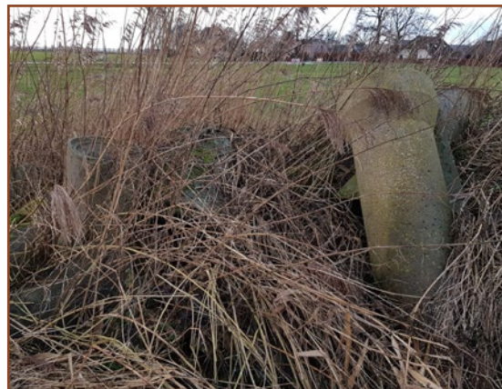
Afb. 2.13: Rietbegroeiing en oude rioolbuizen op de kuilvoeropslag.
