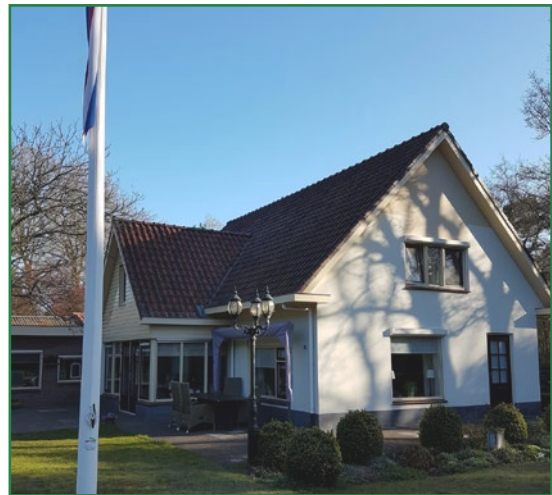
Afbeelding 1.4: De bestaande, te behouden woning waarin huismussen nestelen.
