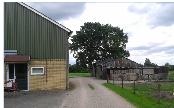
De schuren op het overerf aan de zuidkant van het erf met op de achtergrond waardevolle eiken op de perceelsgrens.
