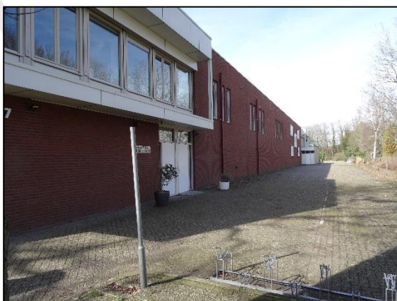
Fig. 2.2, Oostzijde projectgebouw (bron: FF Solutions)
