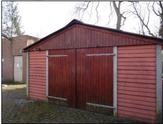
Fig. 2.8, Bijgebouw, geen spouw of dakbeschot (bron: FF Solutions)
