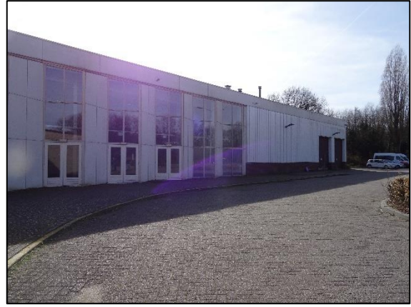
Fig. 2.5, Noordzijde projectgebouw (bron: FF Solutions)
