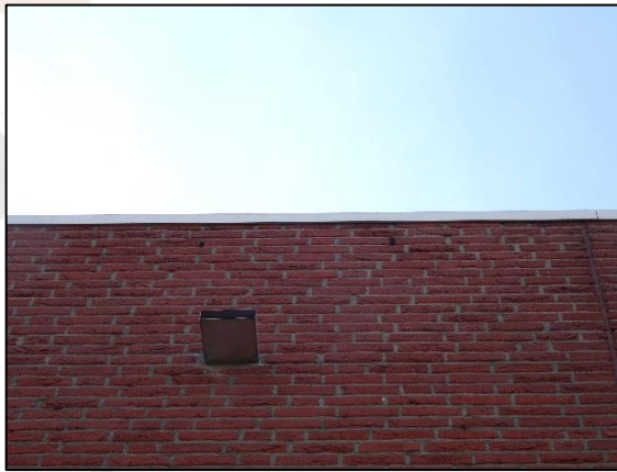
Fig. 2.6, Open stootvoegen (bron: FF Solutions)
