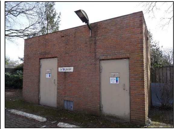
Fig. 2.9, Bijgebouw, geen open stootvoegen (bron: FF Solutions)
