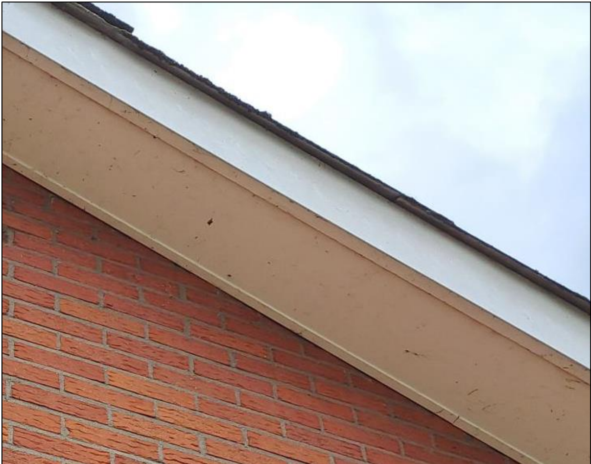
De dak overstek sluit nauw aan op het metselwerk.
