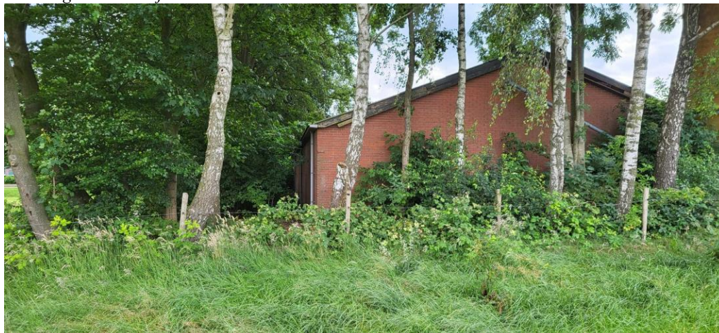
Foto 4: goot noordzijde schuur B
