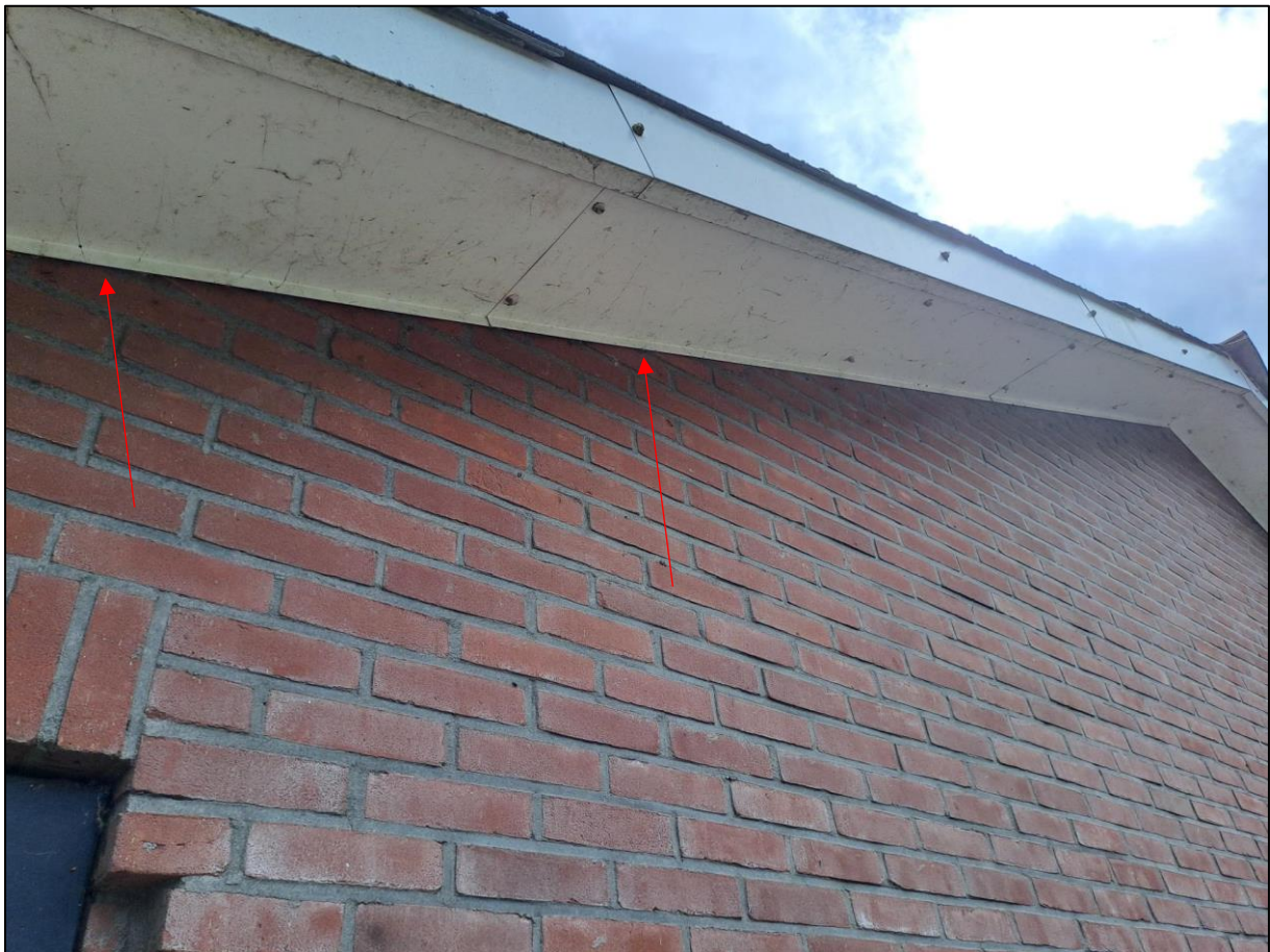
De dak overstek sluit nauw aan op het metselwerk.
