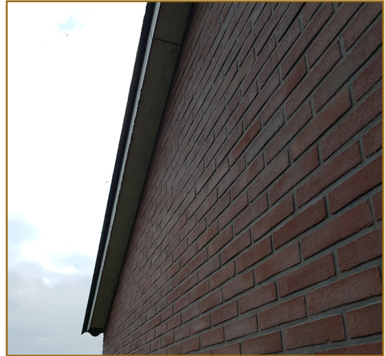
Afbeelding 2.8: Het overstek sluit strak aan op de muur.
