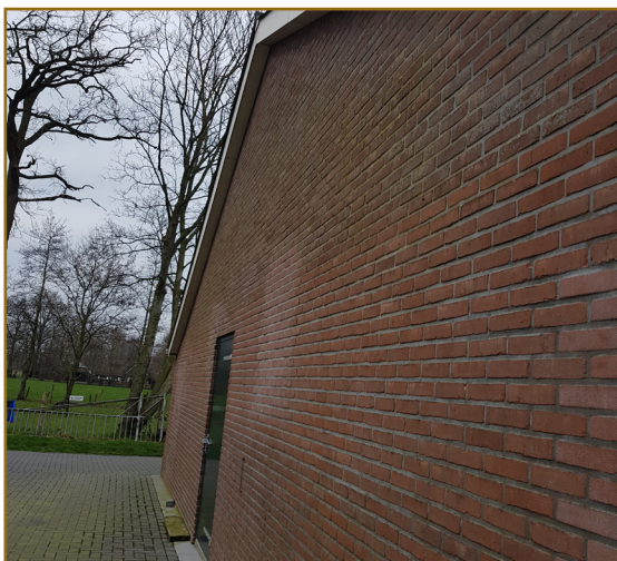
Afbeelding 2.11: Het overstek sluit strak aan op de muur.
