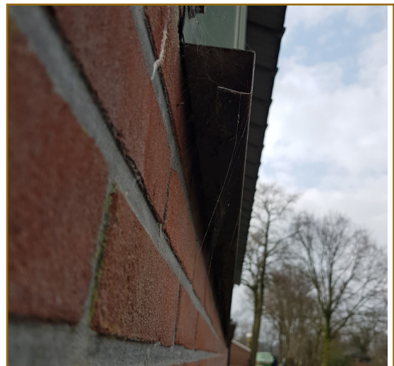
Afbeelding 2.4: Metalen wandbeplating sluit strak aan op de stenen muur van schuur K.
