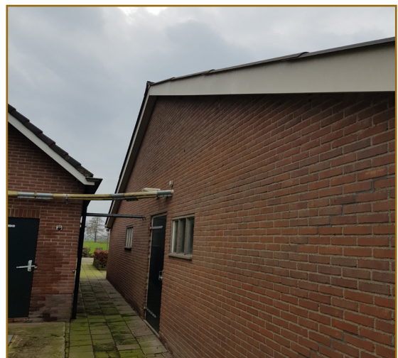
Afbeelding 2.12: Het overstek sluit strak aan op de muur.
