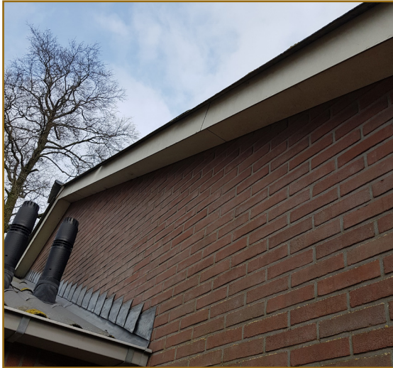
Afbeelding 2.7: Het overstek sluit strak aan op de muur.
