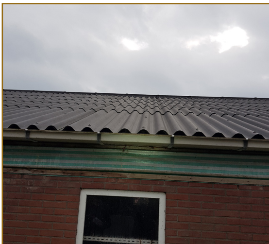
Afbeelding 2.5: Vogelschroot onder de golfplaten.
