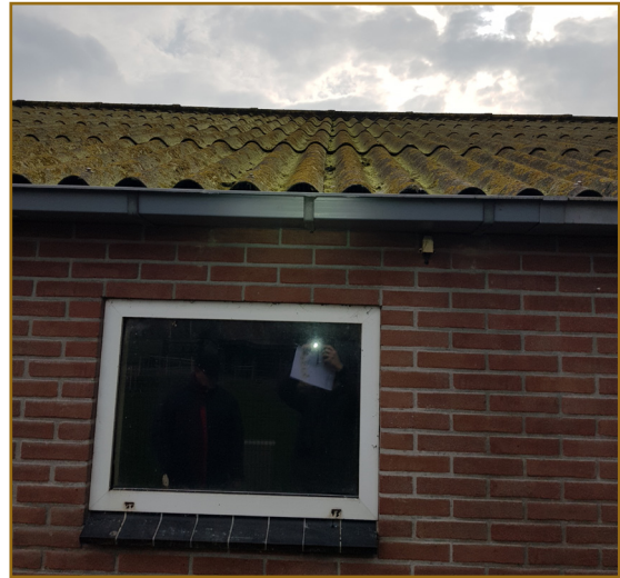
Afbeelding 2.2: Vogelschroot onder de golfplaten.
