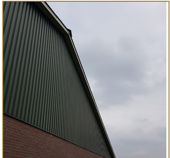
Afbeelding 2.10: Het overstek sluit strak aan op de muur en de metalen wandbeplating is te glad voor vleermuizen.
