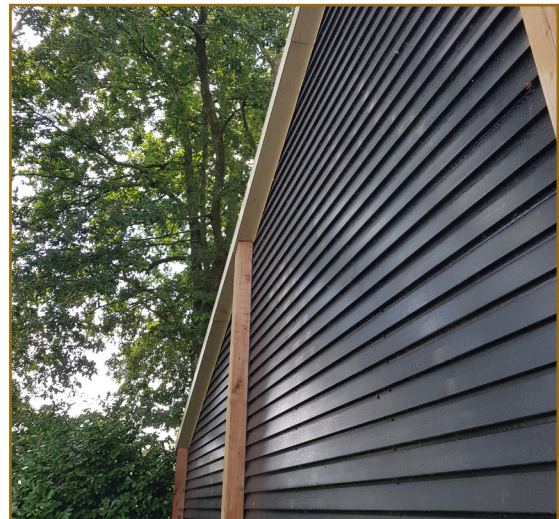
Afbeelding. 2.4: Foto achterkant bedrijfshal.
