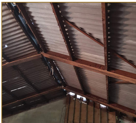
Afbeelding. 2.11: Binnenkant van de oude veeschuur.
