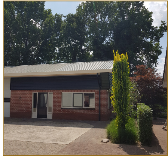
Afbeelding. 2.2: Overzichtsfoto te slopen schuur.
