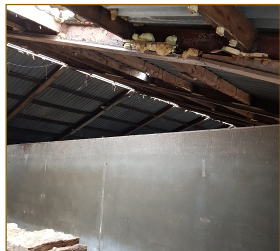
Afbeelding. 2.12: Binnenkant van de oude veeschuur.
