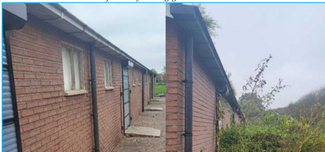
Foto 1: situatie noord- en zuidzijde met afwateringsgoot
