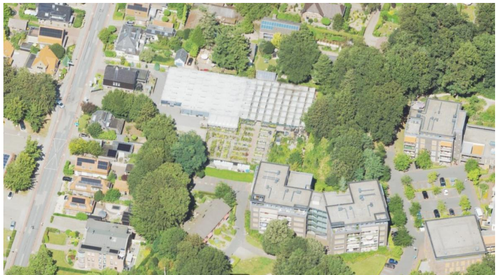
Figuur 2.1: Bestaande situatie
