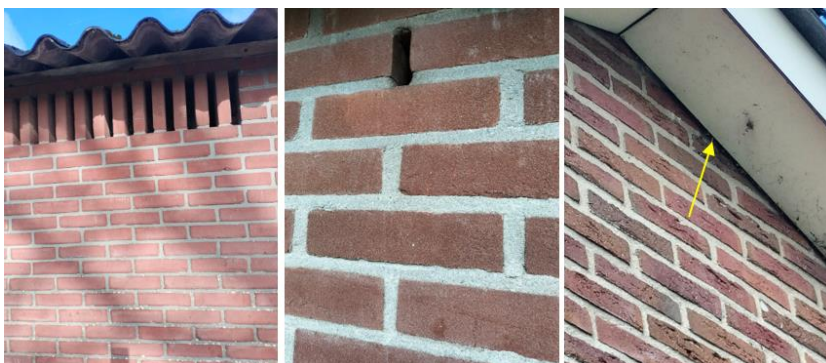
Figuur 7.6 Diverse openingen in de stallen 1 t/m 3 welke mogelijk toegang bieden voor vleermuizen.
