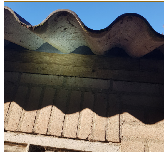
Afbeelding 2.10: Foto van de dichte openingen onder de golfplaten. Er is geen opening voor vleermuizen.
