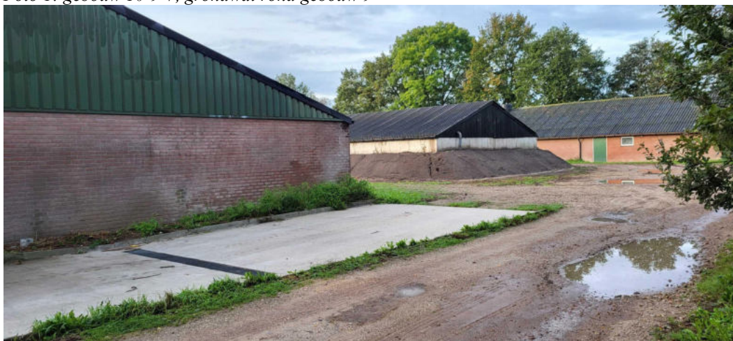
Foto 1: gebouw 10-9-7, grondwal rond gebouw 9
