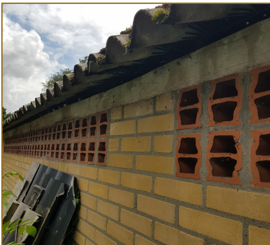
Afbeelding 2.5: Vogelschroot onder de golfplaten van schuur C en de lichte, holle stenen die de bovenkant van de spouwmuur afsluiten.
