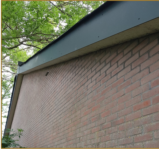
Afbeelding 2.7: Het overstek sluit strak aan op de muur. Westelijke kopgevel van schuur D1.
