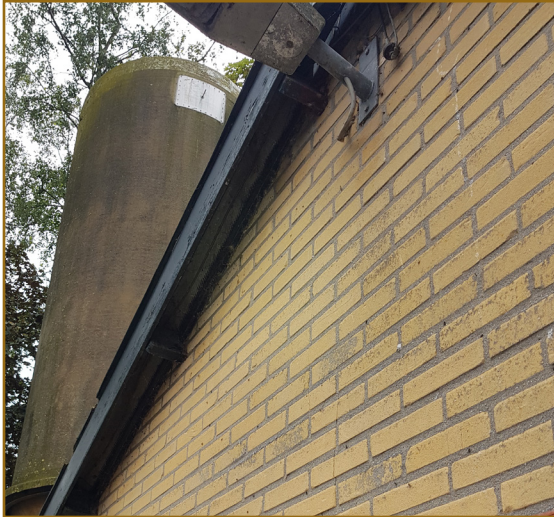
Afbeelding 2.9: Het overstek sluit strak aan op de muur. Oostelijke kopgevel van schuur C.
