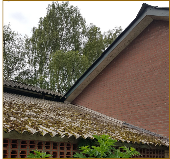
Afbeelding 2.8: Het overstek sluit strak aan op de muur. Oostelijke kopgevel van schuur C1.
