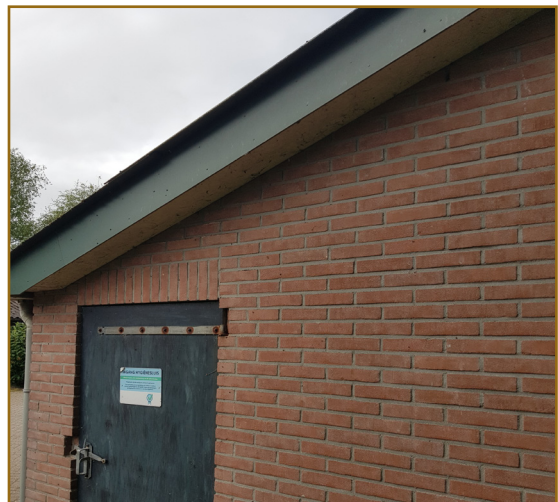
Afbeelding 2.6: Overstek sluit strak aan op de muur. Oostelijke kopgevel van schuur E.
