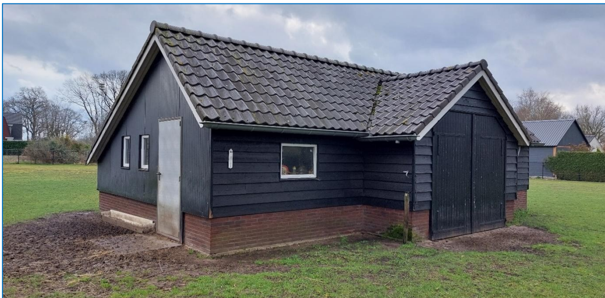
Bestaande bebouwing schapenwei (bron: Bouwbedrijf Kreeft)
