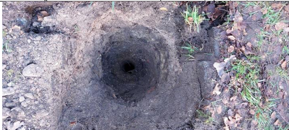
Foto 18: Boring/ Proefgat 013 - Deellocatie 2 – Puinpad
