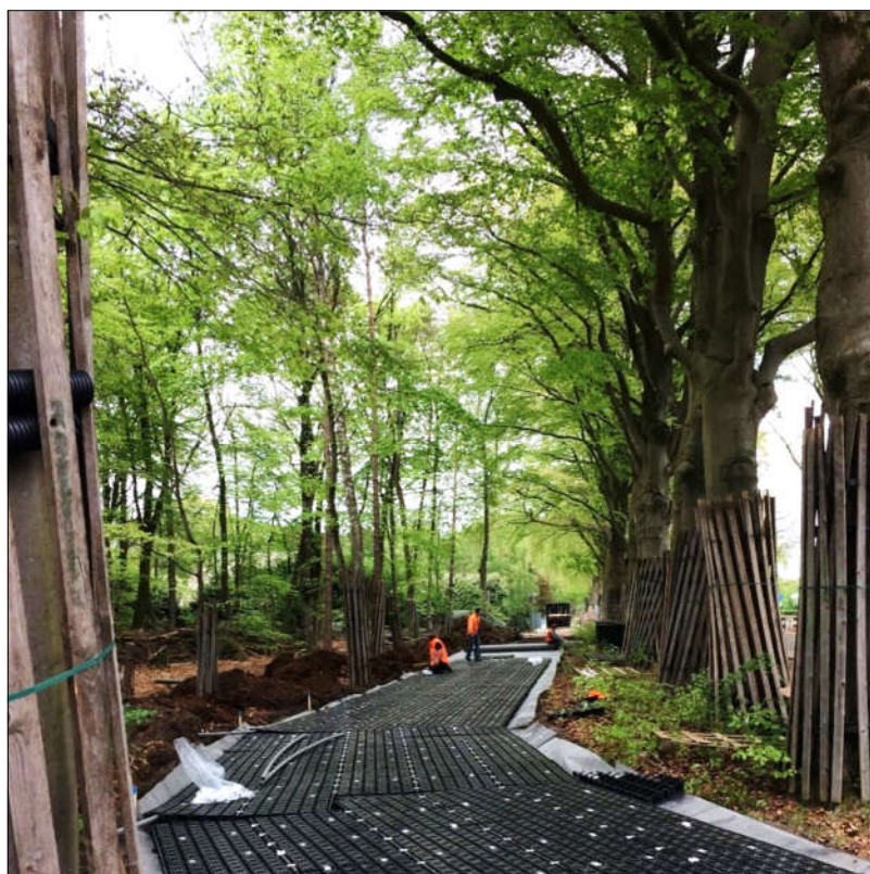
Afbeelding 39: Voorbeeld van een fietspad met Permavoid-kratten in de bewortelde zone van monumentale beuken
