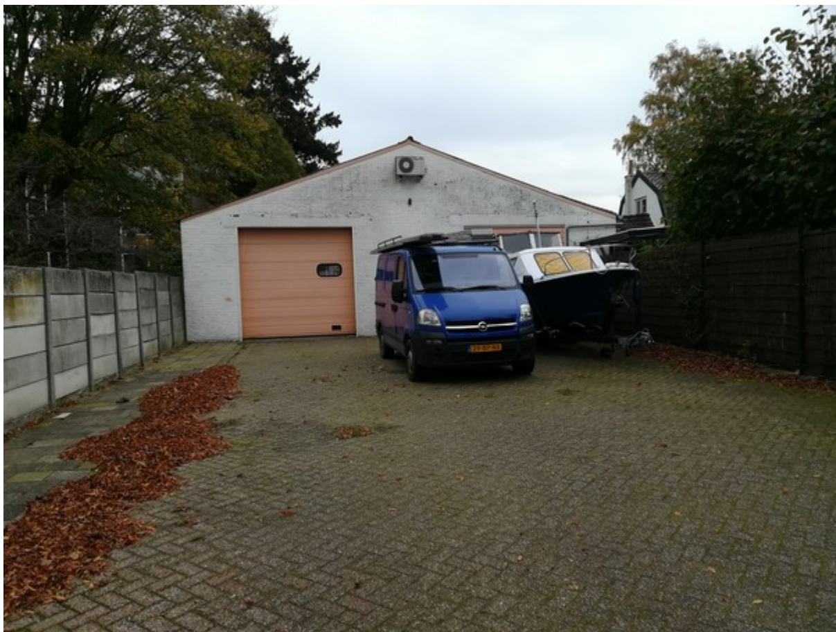
Voorkant van het bedrijfspand, links de begrenzing van het plangebied bestaande uit een betonnenmuur. Foto: M. Oomen, Ecoresult B.V.
