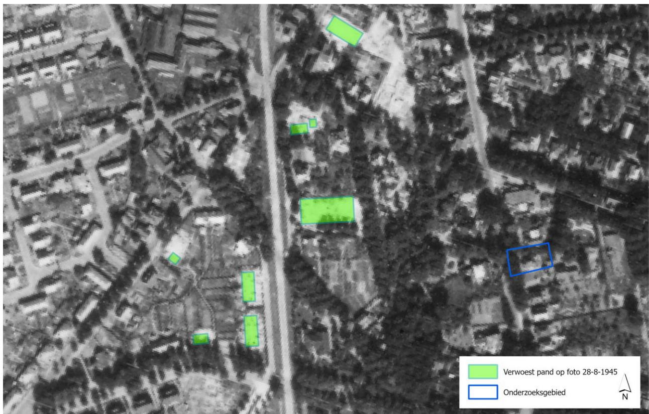
Figuur 10 Luchtfoto van 28 augustus 1945 met ingetekende gesloopte panden
