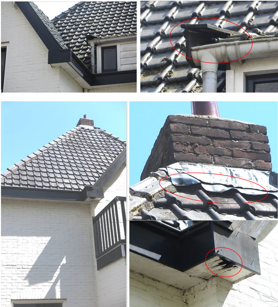
Vervolg figuur 4. Potentiële nest- / verblijfplaatsen van vleermuizen en gierzwaluwen in de opstal aan de Stationsweg 47 te Ede.
