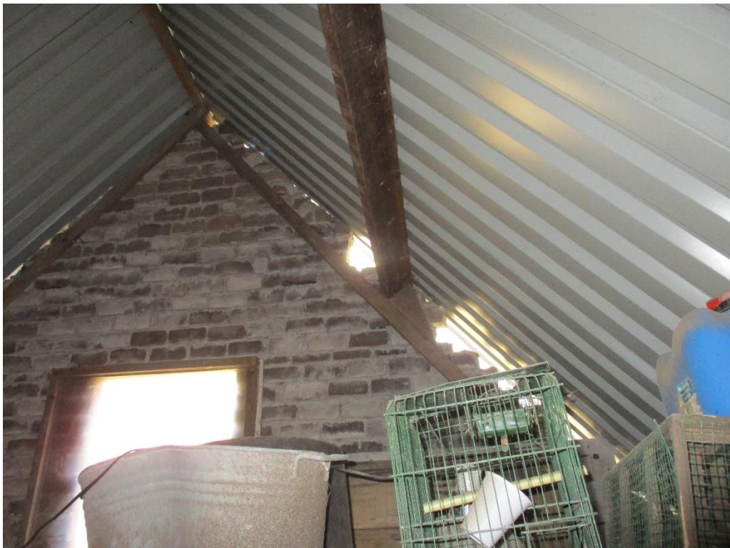
Figuur 4 Muren van de voormalig agrarische stal (C.) enkel gemetseld zonder spouw met een dak zonder dakbeschoet.
