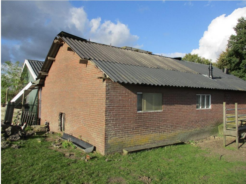
Figuur 3 Gebouw F. omschreven als overkapping met gaten in de muur welke toegang bieden tot de spouw.
