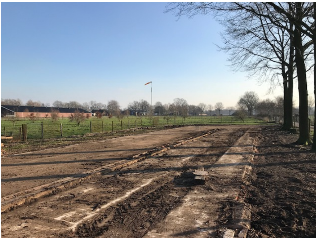
Figuur 4 De restanten van de fundering, door de storm verwoeste, van de pluimveestal aan de oostzijde van de oprit. De foto is genomen richting het zuiden.
