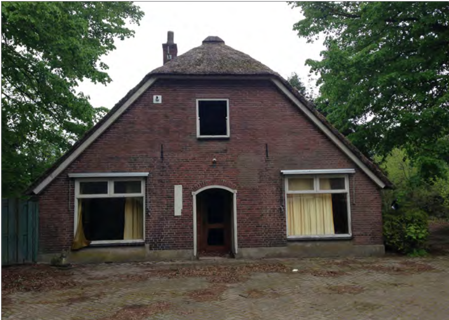
afbeelding | Kopgevel bestaande woning
