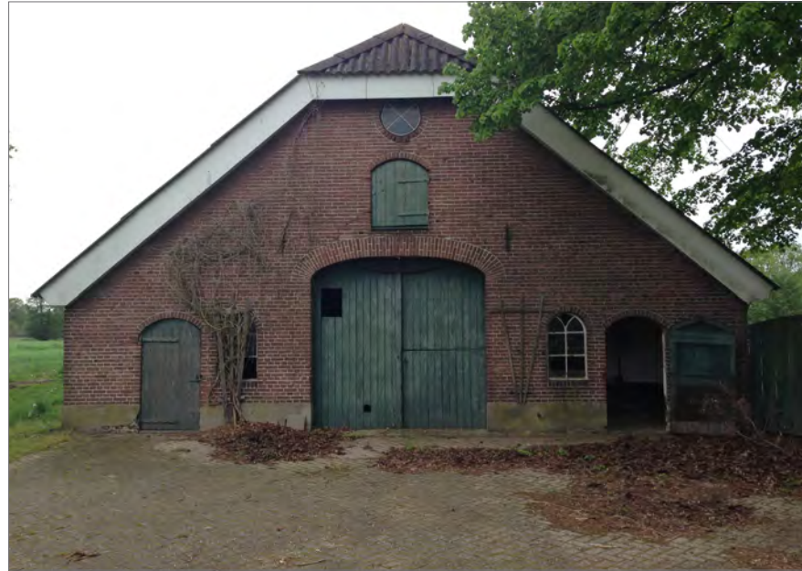
afbeelding | Kopgevel bestaande schuur
