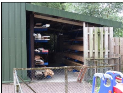
Figuur 9. Te verwijderen overkapping (rechterzijde).
