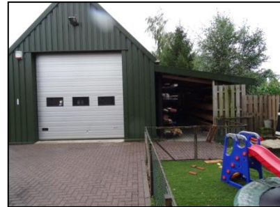
Figuur 8. Te verwijderen overkapping (rechterzijde).
