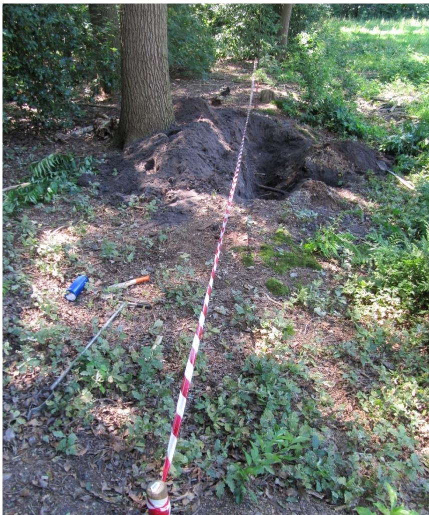
Afbeelding 3. Het lint geeft de geplande funderingslijn weer.
