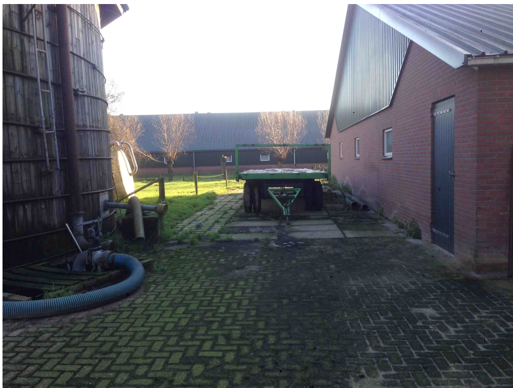
Figuur 3 De stallen zijn opgetrokken uit bakstenen en damwandpanelen. Het terrein is verhard met betonklinkers.
