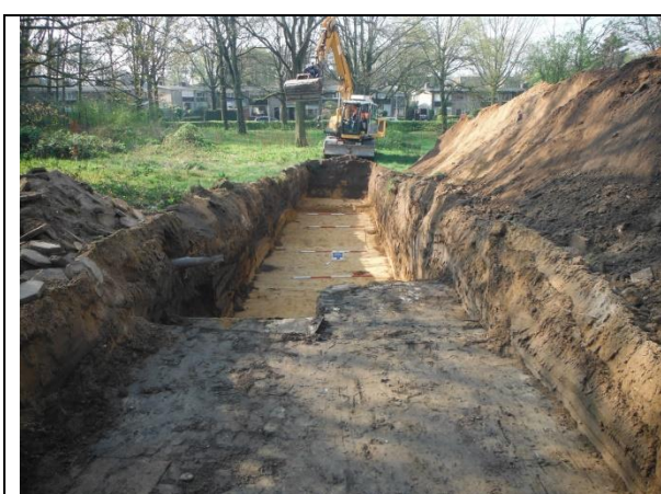
Vlak proefsleuf 1 met op de voorgrond potentieel verontreinigde grond
