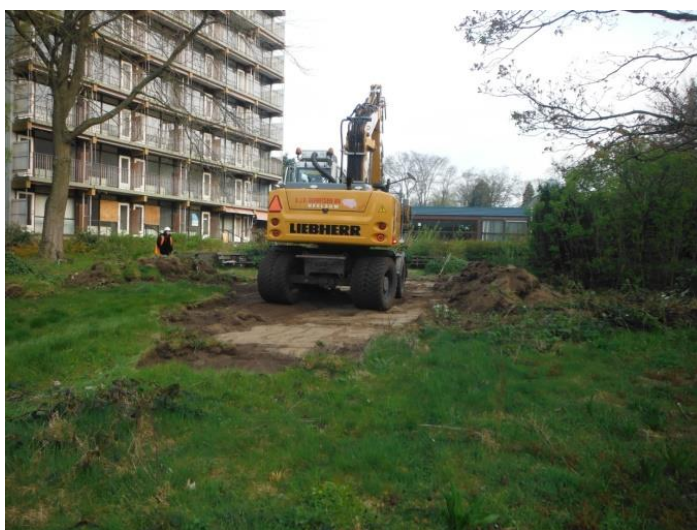
Abbeelding 5 Start proefsleuvenonderzoek in het oostelijke deel van het plangebied, aanleg werkput 1
