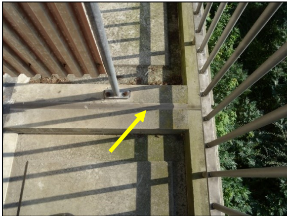
Figuur 12. Overgang tussen balkons met ruimte voor vleermuizen. De overgang is aan de bovenzijde afgedekt met een strip.
