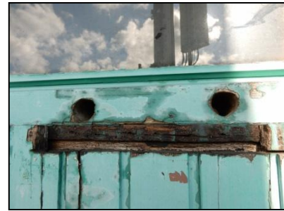
Figuur 16. Gaten die toegang geven tot de technische ruimte boven op het gebouw.
