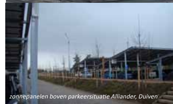
zonnepanelen boven parkeersituatie Alliander, Duiven
