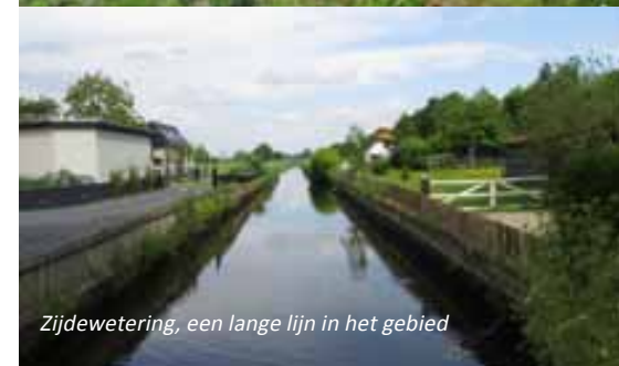
Bestaande watergang Rondweg
