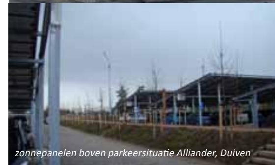
zonnepanelen boven parkeersituatie Alliander, Duiven
