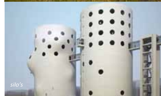
bebouwing langs de A12
