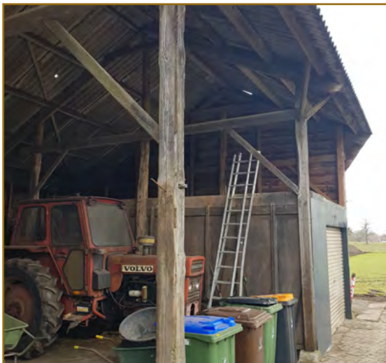
Afb. 2.3: Binnenkant van schuur 7 welke bestaat uit houten muren.
