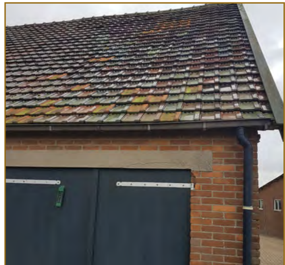
Afb. 2.16: Platte dakpannen op gebouw 6 welke geen ruimte bieden voor nesten van huismussen.
