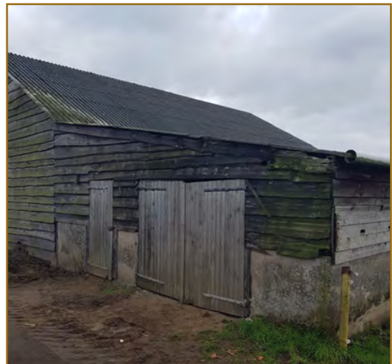
Afb. 2.4: Westkant van schuur 7 en 8. De muren bestaan uit hout.
