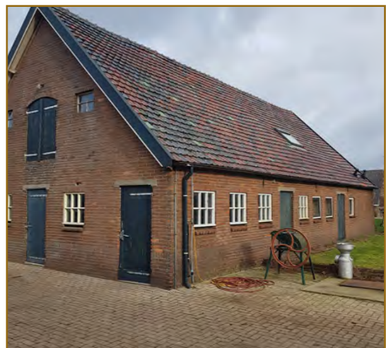
Afb. 2.6: Overzichtsfoto van gebouw 6.
