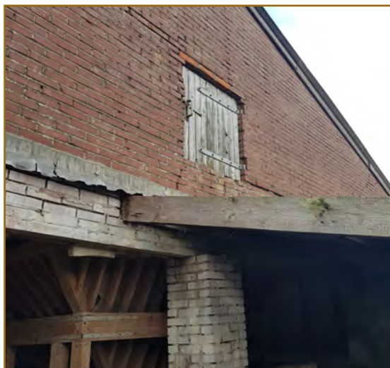
Afb. 2.9: Zuidkant van schuur 5. De boeiplanken zijn te zien.
