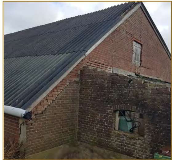
Afb. 2.8: Zuidkant van schuur 5. De boeiplanken zijn te zien.
