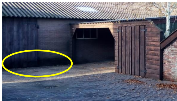
Foto 7: Verder naar het westen (dan foto 6) de rundveeschuur, de dakbedekking ontwatert op een verharding.
