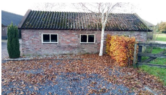
Foto 4: De zuidoostelijk gelegen schuur (voorheen voor mestvarkens). Er is deels een halfverharding bestaande uit grind aanwezig.
