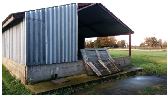
Foto 9: De overdekte mestplaat ten westen van de kalverenschuur: geen asbestverdachte dakbedekking.
