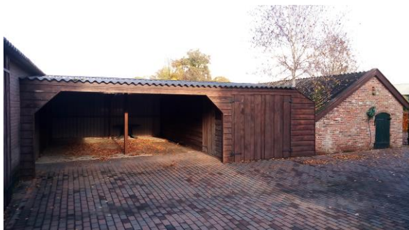
Foto 6: Schuur /carport ten westen van foto's 4 en 5: de dakbedekking ontwatert op een verharding.
