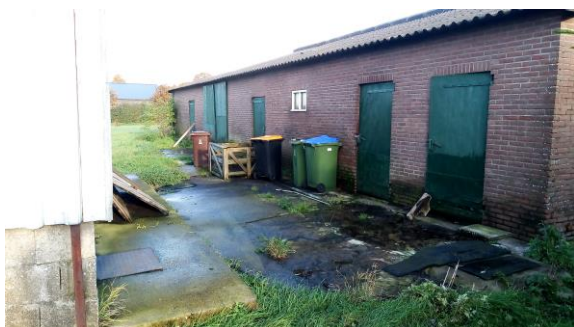
Foto 8: De westzijde (achterzijde vanaf de weg) van de rundveeschuur: de dakbedekking ontwaterd op een verharding.
