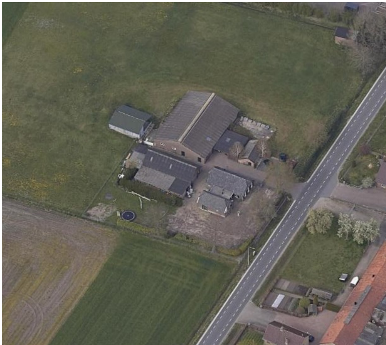
Afbeelding 2.1: Luchtfoto bestaande situatie
