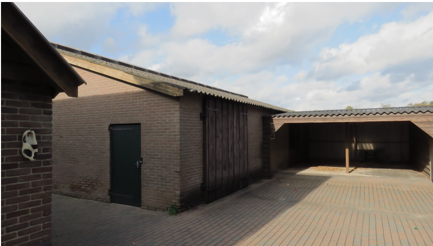
Afbeelding 8: Links opstal B, rechts opstal C, deze opstal bestaat uit een deels open houtconstructie met een golfplaten afdak en achterwand.
