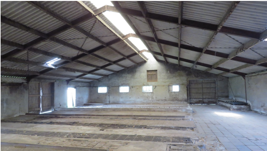
Afbeelding 7: Binnenzijde opstal B. De muren zijn steenconstructies, het dak is opgebouwd uit staal en golfplaten.
