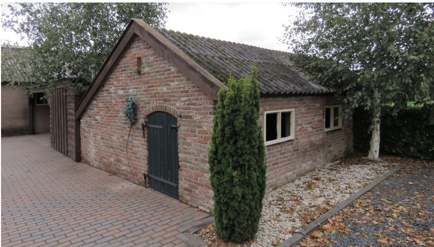
Afbeelding 9: Opstal D, een lage schuur opgebouwd uit baksteen. Het dak bestaat uit een houtconstructie met golfplaten, aan de binnenzijde van dit dakvlak bevinden zich oude isolatiepanelen.
