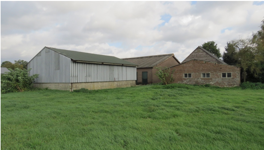
Afbeelding 4: Zicht op het plangebied vanuit het westen. Links bevindt zich opstal A.
