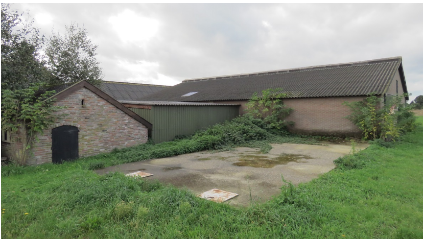
Afbeelding 6: Zicht op het plangebied vanuit het oosten. Links: opstal D, midden: opstal C, rechts: opstal B.
