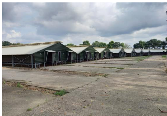
Foto 10: Geïventariseerde shed 2 t/m 12 vanuit zuidwestelijke richting gezien.
