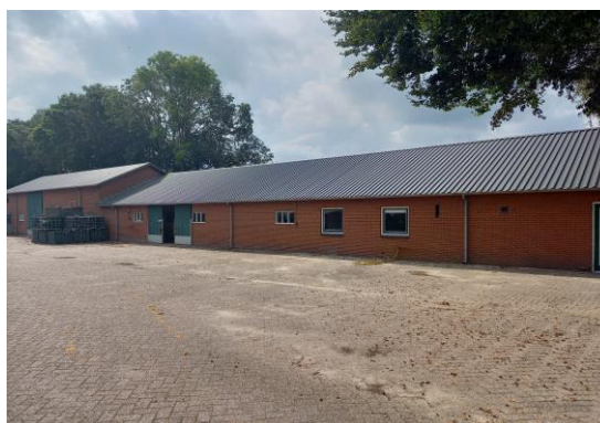
Foto 4: Geïnvventariseerde schuur 1 vanuit noordoostelijke richting gezien. (geen asbest waargenomen)
