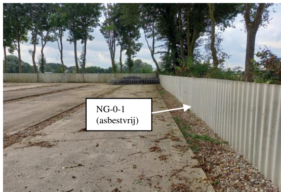
Foto 1: Geïnvventariseerde schutting bestaande uit asbestvrije golfplaten, middels waargenomen NT-code. (zie foto 2)
