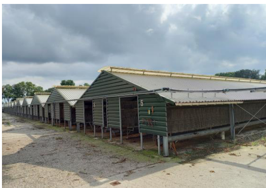
Foto 9: Geïventariseerde shed 2 t/m 12 vanuit noordwestelijke richting gezien.
