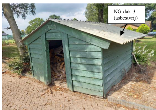
Foto 6: Geïnvventariseerde schuur 3 met asbestvrije golfplaat als dakbedekking vanuit zuidoostelijke richting gezien. (NT-code waargenomen) Golfplaten zijn identiek aan NG-0-1.
