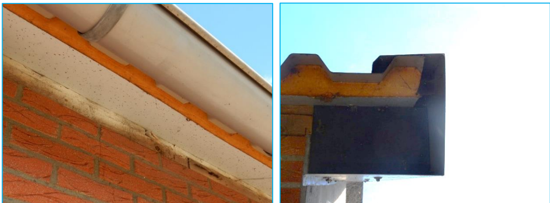
Foto: Houtenbalken dichten de spouw van de werktuigenberging aan de bovenzijde af en sandwichpanelen ongeschikt voor vogels en vleermuizen.
