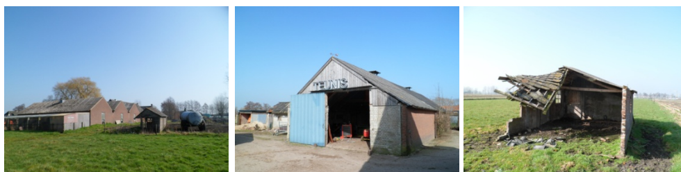
Foto's: Indrukken plangebied. De te slopen opstallen.
